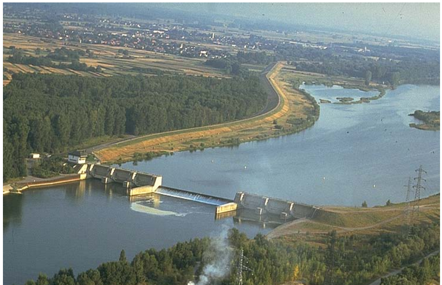
Bild 2: Blick auf das Kulturwehr Kehl / Oberrhein
